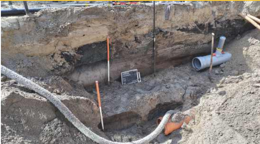
Sfeerimpressie van het opnemen van profielen in een rioolsleuf. Deze profielkolom is op de top van het duin gedocumenteerd. (Foto: IDDS)
