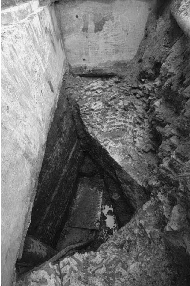
Afb. 8. Amsterdam * Nieuwmarkt. Fundering van de Metselaarstoren van de Waag. De brede gemetselde hoek van oranje baksteen maakte onderdeel uit van de stadsmuur uit 1488 (foto: Bureau Monumenten en Archeologie, J. Veerkamp).
