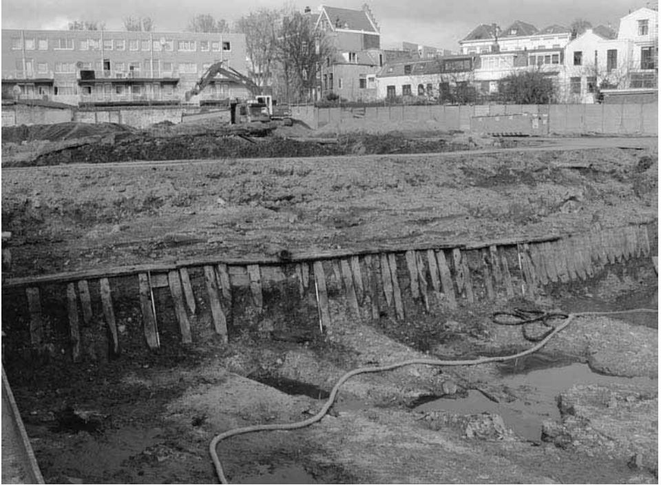
Afb. 47. Rotterdam – Delfshaven * Stadtswerf. Vooraanzicht van een gedeelte van de kadebeschoeiing.
