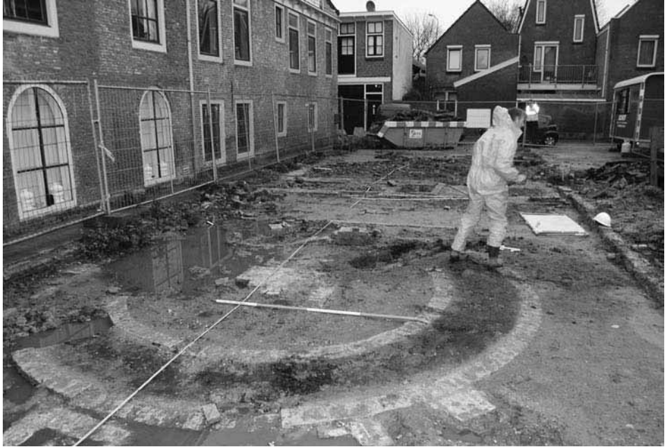
Afb. 4. Alkmaar * Spanjaardstraat. Laat-18de-eeuwse rosmolen van cichoreifabriek De Burg, gezien vanuit het zuiden met op de achtergrond de Spanjaardstraat.
