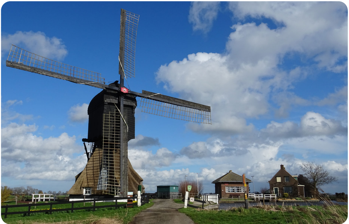
De Westermolen, het elektrisch gemaal, het dieselgemaal en de woning (Foto: Ellen Steendam)
